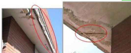
Figura 2 Esempio intonaco cornicione lesionato e fessurato
