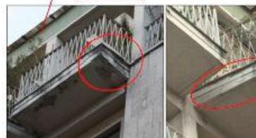
Figura 4 Esempio intonaco balcone lesionato e fessurato
